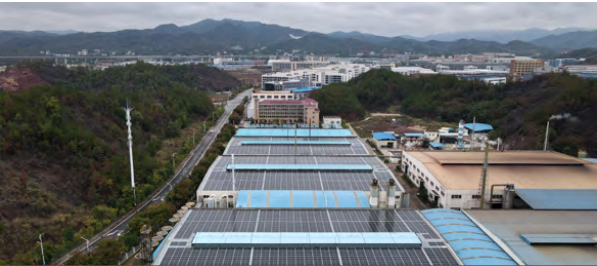
集团所属企业赣州友力车间顶棚光伏发电组年供电150余万千瓦时、减排二氧化碳约1132吨、节约电费30余万元，节能降碳成效明显。
