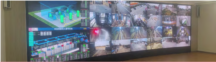
山东稀土完善破碎集中控制系统、压风机远程控制系统、中央泵房无人值守系统、主通风机远程控制系统、中央配电室控制系统等，实现各子系统之间的数据信息共享，统一平台展示，关键工序及设备均实现智能化控制和精确指挥调度。
