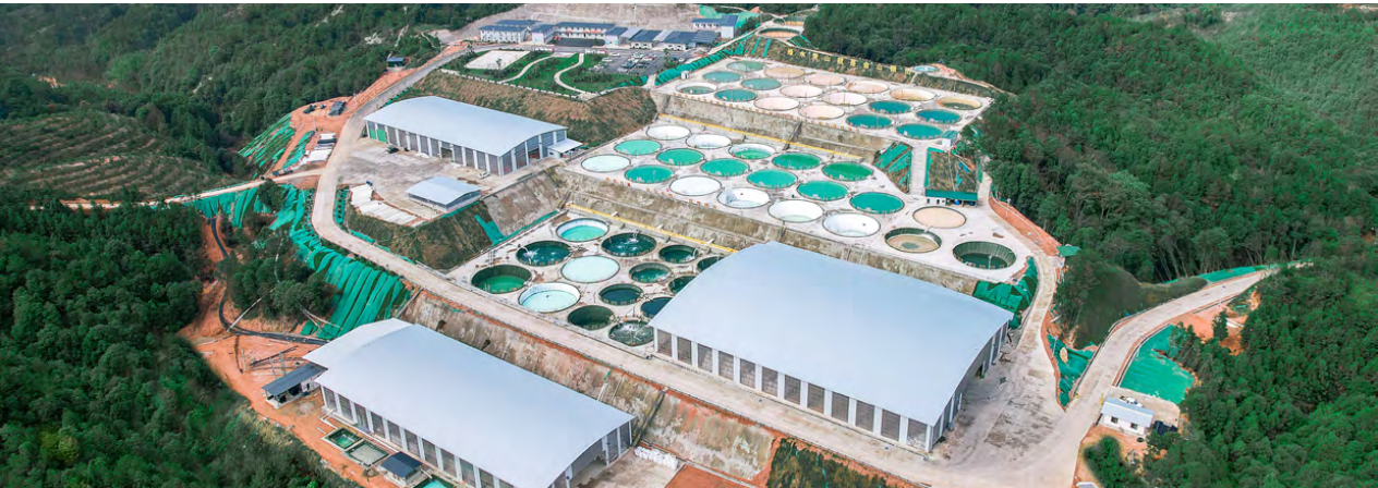
定南木子山矿山修复后实景
